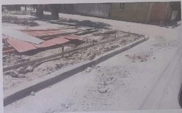
Construcción y Remodelación de Aceras
