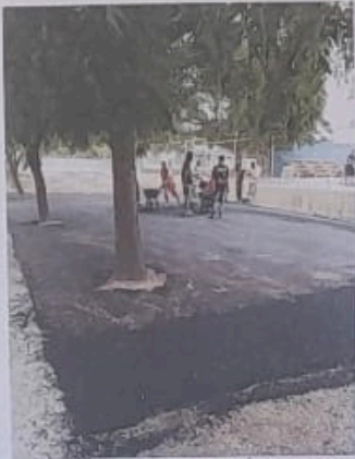
ASFALTADO AL FRENTE DE LA FUNERARIA
