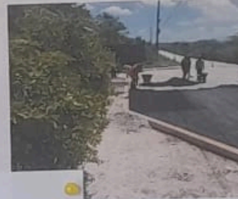
Asfaltado de la Entrada
