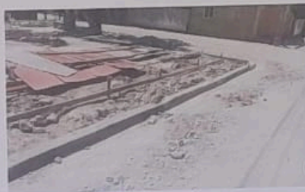
Construcción y Remodelación de Aceras
